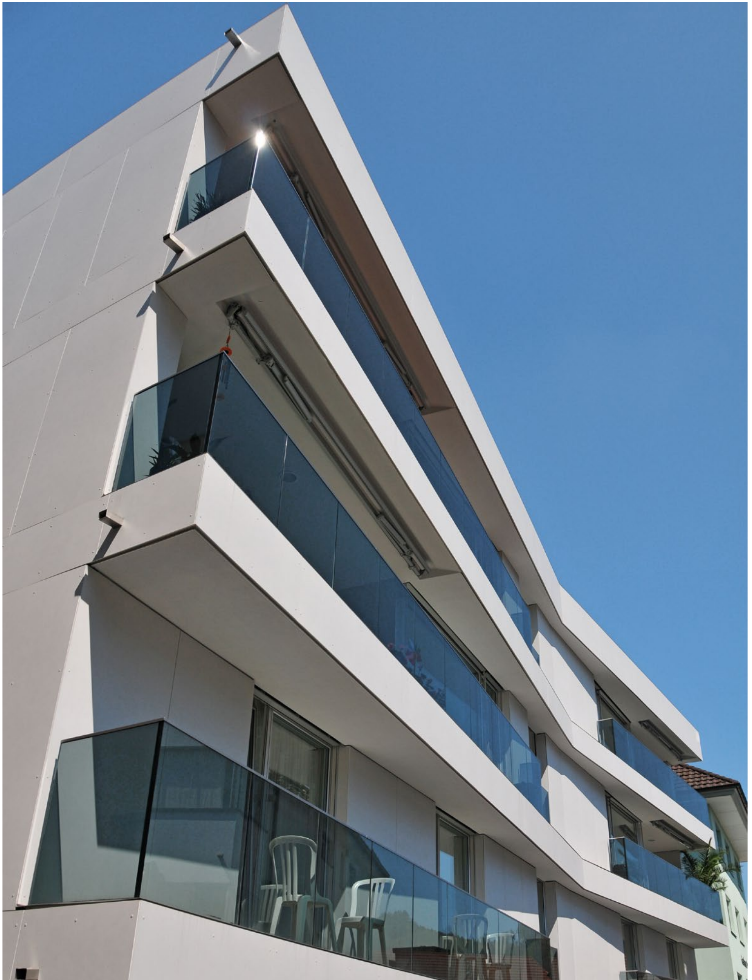
Überbauung Post, Willisau Transformation de la poste, Willisau Trasformazione della posta, Willisau
