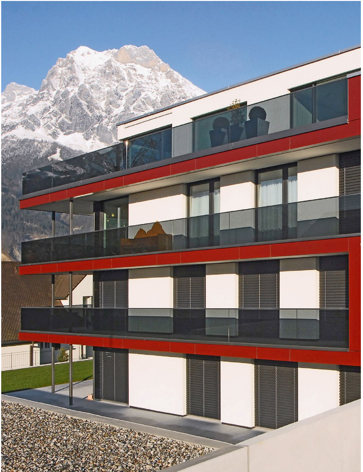
Mehrfamilienhaus, Altdorf Maison familiale, Altdorf Casa familiare , Altdorf
